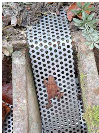
Links: Arbeiten beim Eibau der Ausstiegshilfe. Rechts: Junge Erdkröte kurz vor dem Ausstieg
