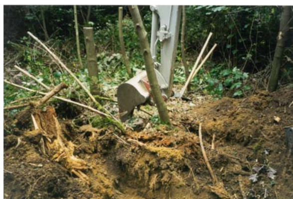
Abb. 3: Mit einem Minibagger werden zunächst seitliche Hilfsgräben angelegt.
