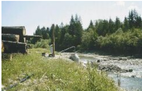
Abb. 15: Wasserentnahme aus einem Fließgewässer [Foto: LWF]
