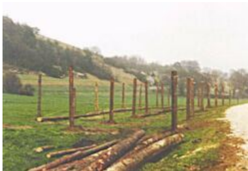
Abb. 24: Holzboxen im Bau [Foto: FUNK]
