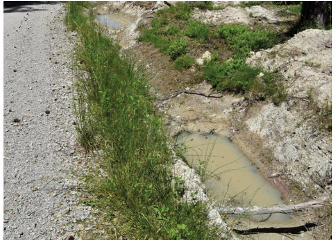
Kleingewässer können mit wenig Aufwand z. B. durch eine kaskadenartige Profilierung in Wegseitengräben angelegt werden.
