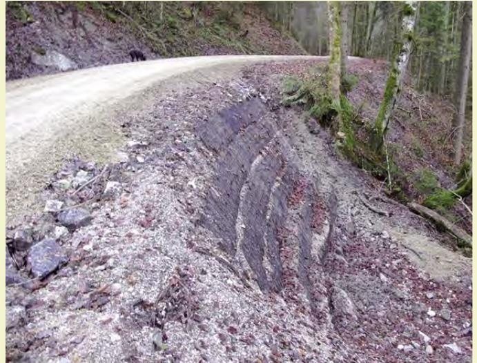
Wichtig ist, dass zumindest die unterste Lage wasserdurchlässig ist und eine baldige Begrünung der Böschung stattfindet, da das Geogitter vor UV-Strahlung geschützt werden muss, um dauerhaft seine Funktion erfüllen zu können. Die unterste Lage wurde deshalb mit einer Reihe Wasserbausteine »verblandet«, um gleichzeitig Wasserdurchlässigkeit und Beschattung dauerhaft zu gewährleisten.
