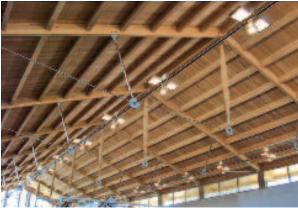
Abbildung 17 und 19: Produktionshalle aus Eichenbrettschichtholz, Weingut Vega Sicilia (Spanien)
