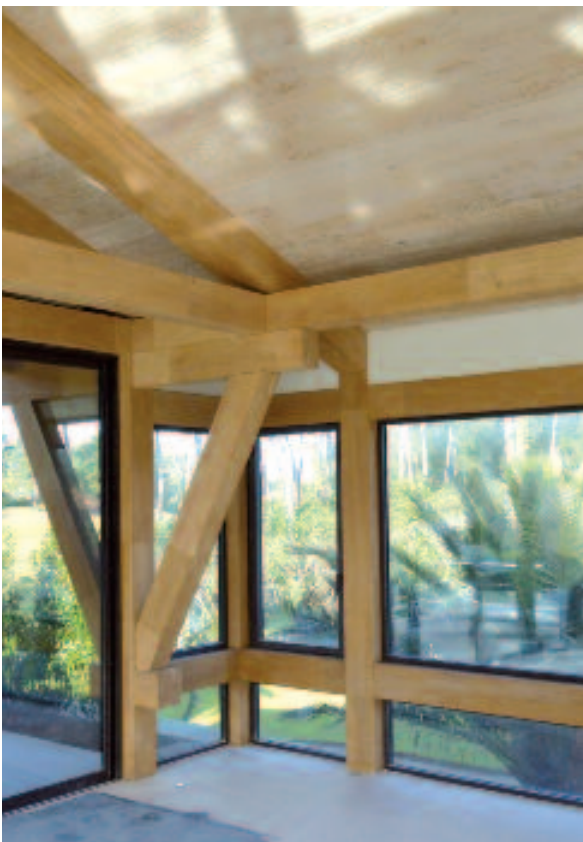
Abbildung 18: Eichenbrettschichtholz im modernen Einfamilienhausbau in Frankreich. Foto: EYF Gámiz, S.A. - © SIMONIN S.A.S.
