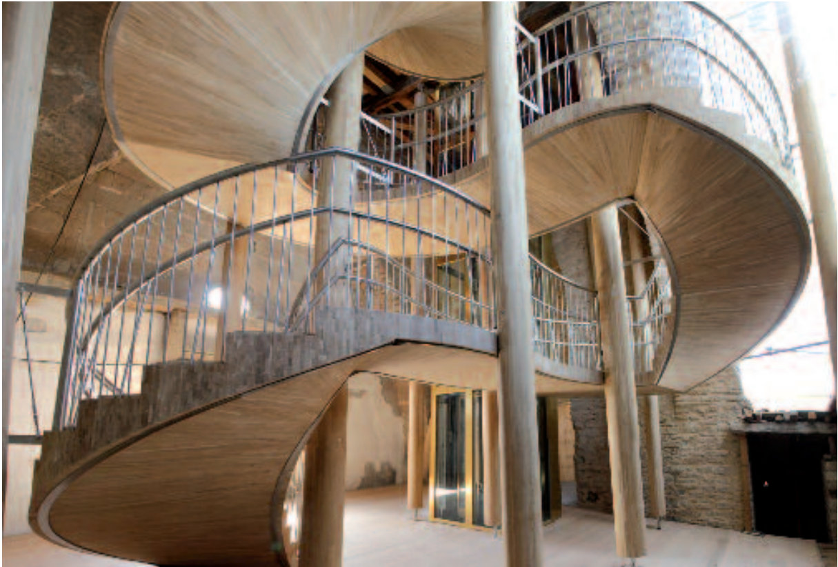
Abbildung 20: Rundgefrästes Eichenbrettschichtholz stützt die moderne Konstruktion in der Kathedrale Santa Maria in Viktoria (15. Jhd., Spanien) Foto: EYF Gámiz, S.A.
