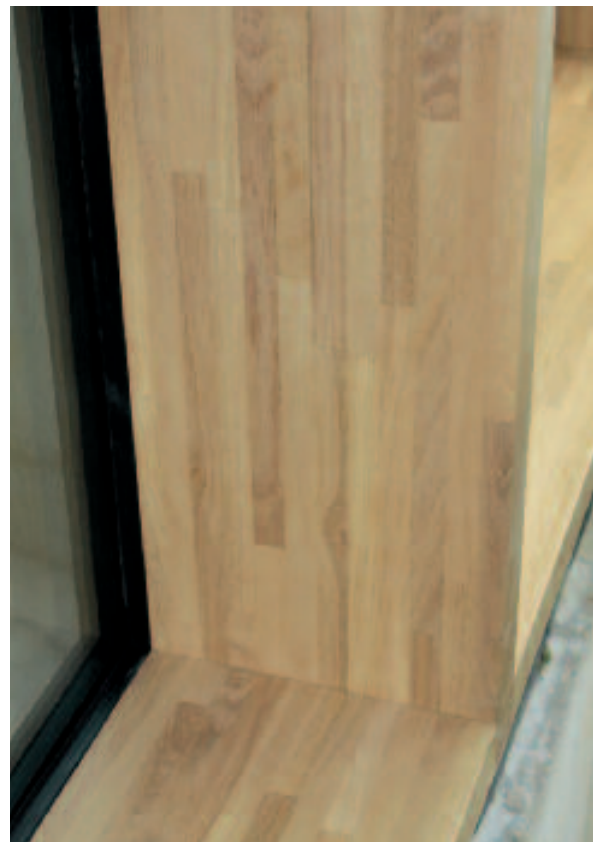
Abbildung 16: Eichen-Pfosten-Riegel Foto: EYF Gámiz, S.A. – © Seufert-Niklaus GmbH
