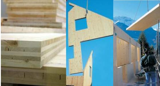
Abb. 91: Anwendungen für Mehrschichtige Massivholzplatten (Quelle: [www.finnforest.de](http://www.finnforest.de))
