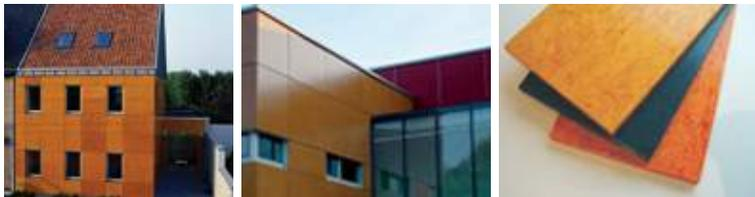
Abb. 92: OSB mit Coelan high solid Beschichtung (Quelle: [www.egger.com](http://www.egger.com))
