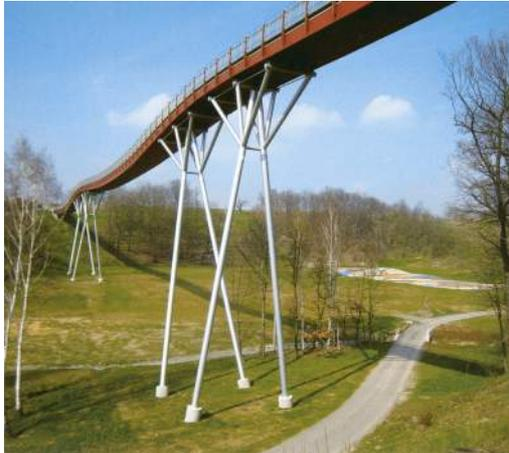
**Abb. 102: Spannbandbrücke Ronneburg (Quelle: [www.infoholz.de](http://www.infoholz.de))**
