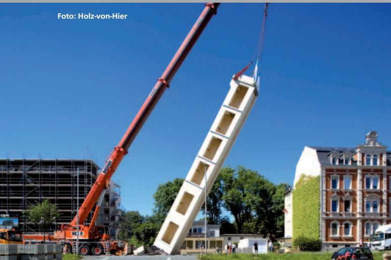
Der Aufzugschacht für ein Schülerwohnheim in Rehau wird angesetzt. Für das mehrstöckige Gebäude wurden 450 m<sup>3</sup> Holz verbaut und 670 km »kumulierter Gesamtweg« zurückgelegt.
