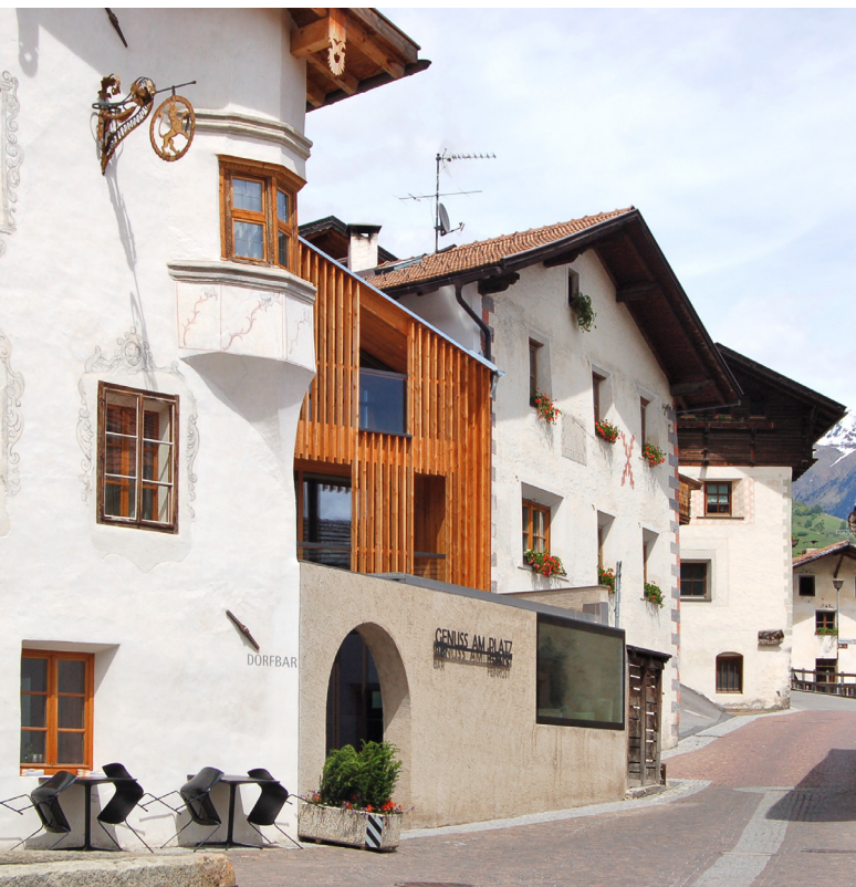
Mals, Burgeis. Ansitz zum Löwen, Stallersatzbau, Bar und Laden Genuss am Platz als Erweiterung des Hotels Weißes Kreuz mit Stammhaus am Platz gegenüber. Das Hotel wächst im schrittweisen Umbauen und Ergänzen im Bestand (Ladurner & Marx Architekten), schafft Nutzungen auch für Einheimische und belebt den schönsten Platz im Ort.
