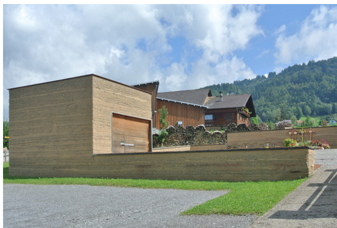
Friedhofskapelle Batschuns Zwischenwasser, Marte.Marte Architekten. Am Bau aus Stampflehm war die Bürgerschaft beteiligt unter Anleitung des Lehmbauspezialisten Martin Rauch, auch um vertretbare Kosten zu erzielen. Die gemeinschaftliche handwerkliche Realisierung führte zu enger Verbundenheit des Ortes mit zeitgenössischem Bauen.
