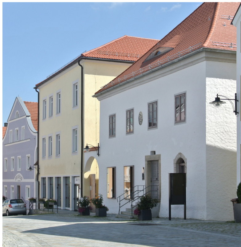
Perlesreut. Bauhütte Ilzer Land als Einrichtung und Anschauungsprojekt für Leerstandsaktivierung und Innenentwicklung, gefördert von der Bayerischen Dorferneuerung und Städtebauförderung. Sanierung und Umbau zur Bibliothek, Büros, Wohnen: Andreas Schmöller, Passau.
