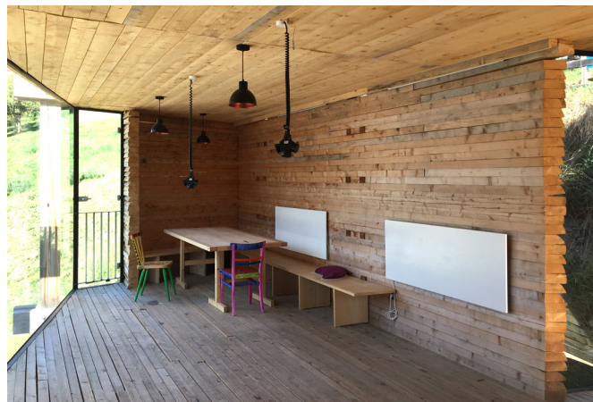
Freiraumklasse der Mittelschule Fließ: ein durch Fachleute angeleitetes, mehrjähriges baukulturelles Lehr- und Lernprojekt. Die Schüler sind am gesamten Entstehungsprozess beteiligt: beim Holzfällen im Gemeindefeld, im Sägewerk, bei der Projektierung nach dem Entwurf des Fließler Elias Walch, Kostenplanung bis zur handwerklichen Ausführung der Vollholzkonstruktion aus sägerauen, geschichteten Brettern.
