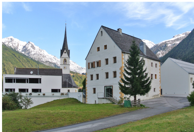
Kals am Großglockner. Die Ortsmitte mit öffentlichen Neu- und Umbauten von Schneider & Lengauer Architekten ist Zeichen für einen Neuanfang nach langem Stillstand. Auch hier vermittelte die Tiroler Dorferneuerung mit Gestaltungsbeirat ein neues Baukulturverständnis.
