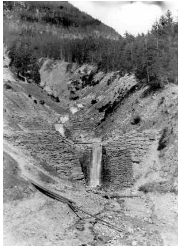
Abbildung 1: Historische Sperrenstaffel am Wustbach Foto: Wasserwirtschaftsamt Kempten
