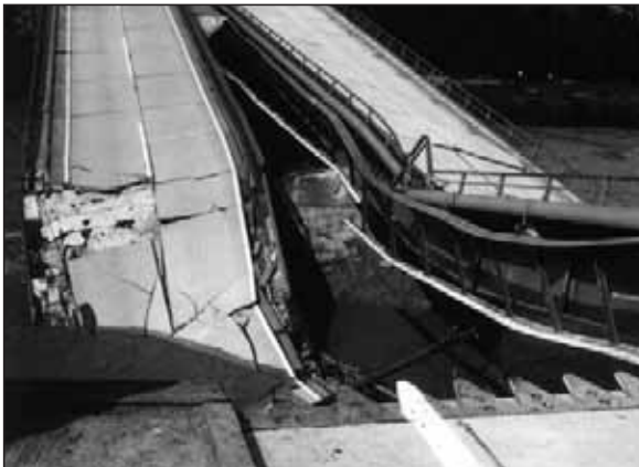
Abb. 3: Eingestürzte Autobahnbrücke bei Lieferung (Foto: Ständige Gewässerkommission nach dem Regensburger Vertrag)
