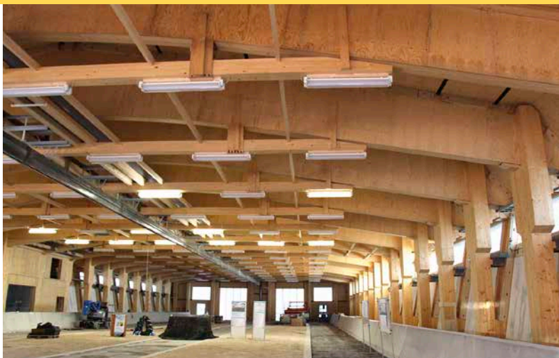
Foto: Rubner Holzbau
