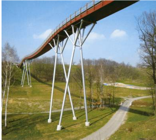
Abb. 102: Spannbandbrücke Ronneburg (Quelle: www.infoholz.de )
