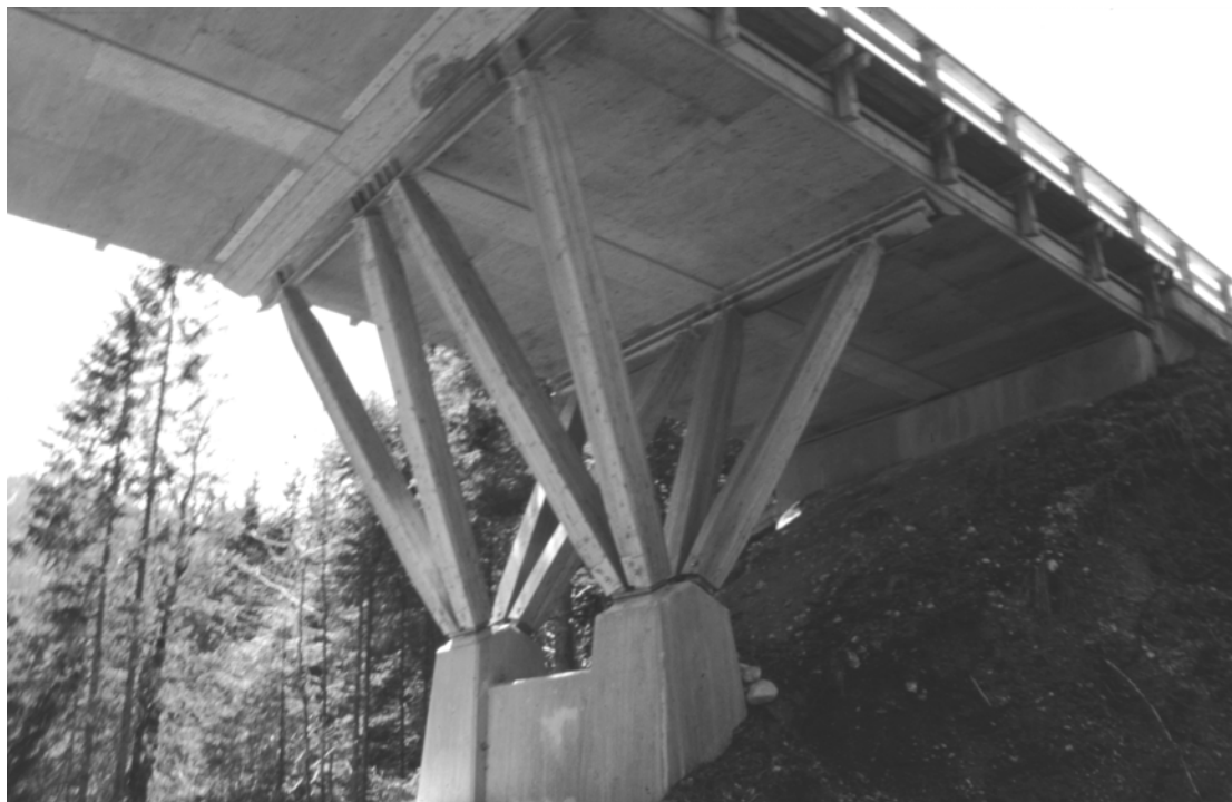
Abb. 2: ..... 34 m lange Holzbrücke zwischen Wallgau und Vorderriß
